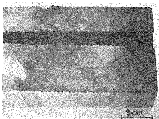
Fig.2. Aspecto de uma superfície de fractura.
