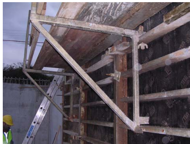
Fig. 2. Sistema de andamiaje
