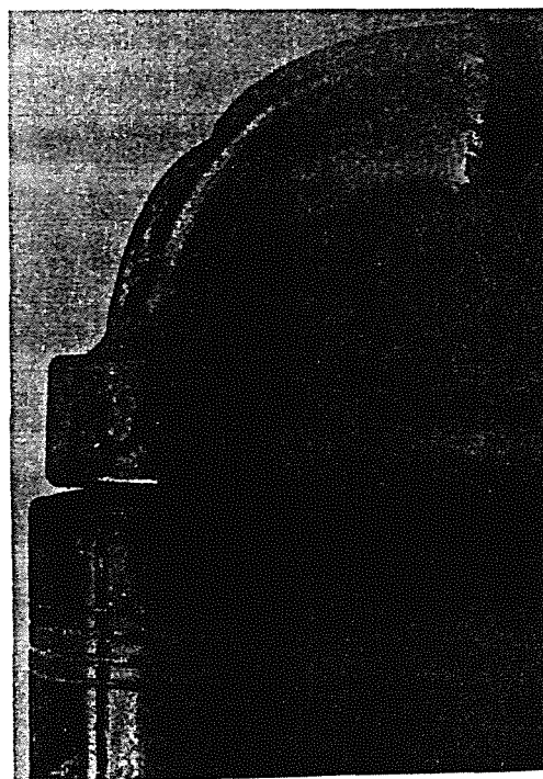
Fig. 4. Conector usado roto, que había sido suministrado por la Empresa A. La rotura se ha producido por la garganta soldada.
