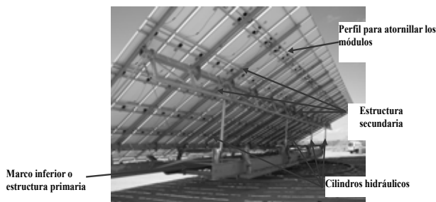
Figura 2. Esquema del seguidor solar.
