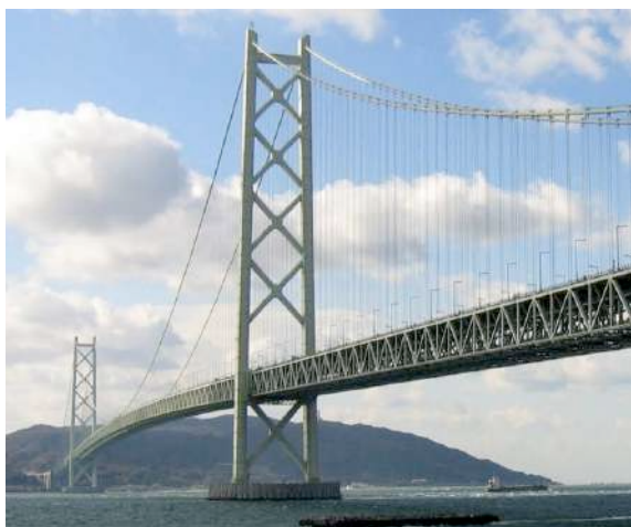
Fig. 4. Puente Akashi Kaikyō en Kobe (Japón).
