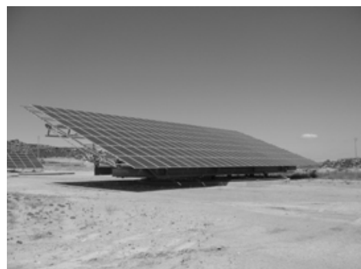
Figura 1. Fotografía general del seguidor analizado.
