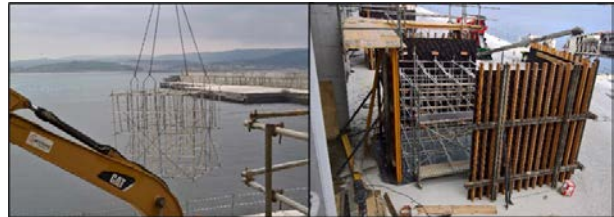
Figura 1. Punta Langosteira. Armadura GFRP en distintas fases de fabricación de los bloques.
