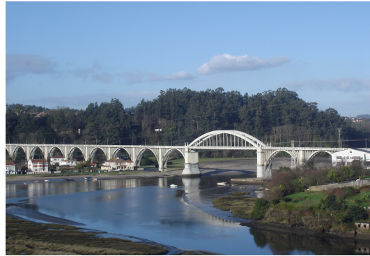
Fig. 3. Puente del Pedrido en La Coruña (Galicia, España).
